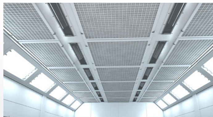
Plenum avec lumières allumées pendant la phase de peinture Plenum con luces encendidas durante la fase de pintura
